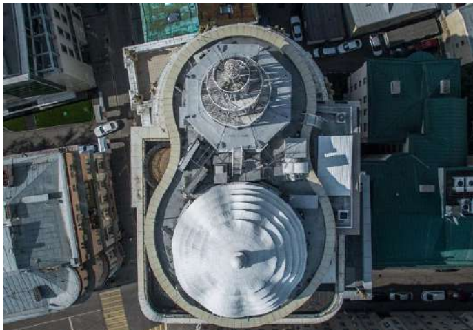
Гидроизоляция кровли полимочевиной
