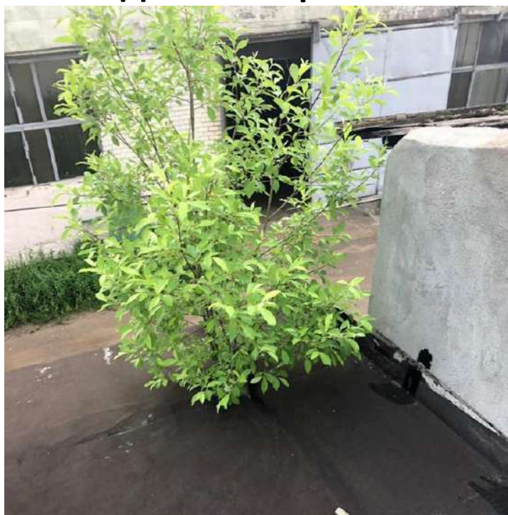
До начала работ
